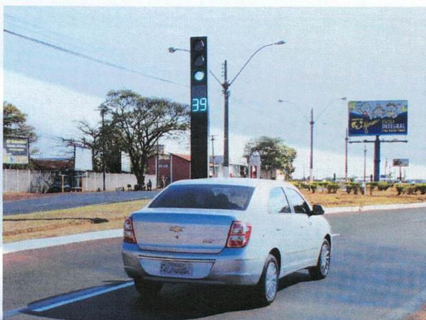
Figura 4.1 – Foto de totem semafórico colocado de um único lado indicando luz verde.
