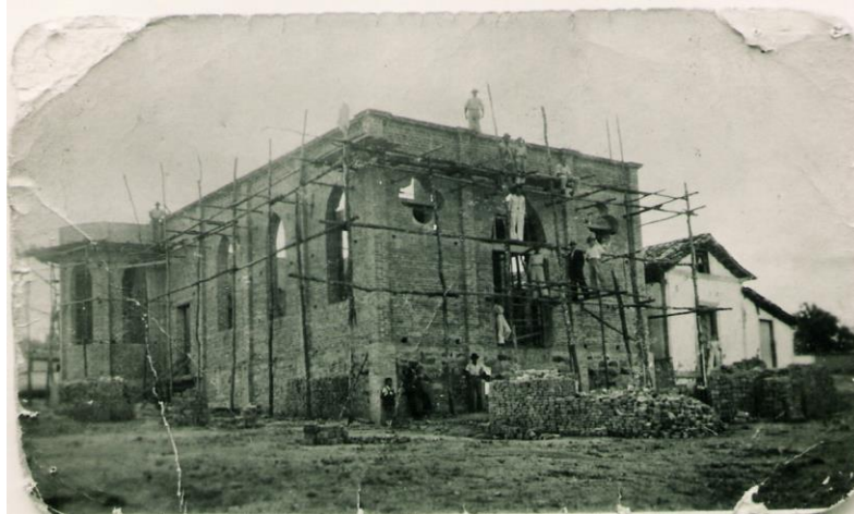
Figura 2 - Obras de construção da Igreja de São Sebastião
