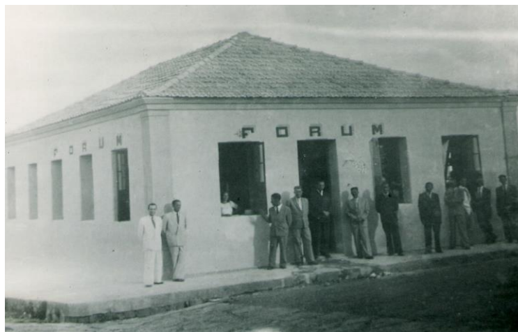
Figura 6 – Prédio do Fórum da Comarca
