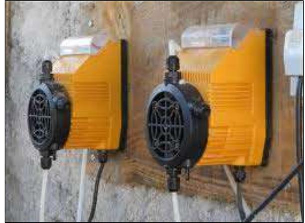
Figura 18 – Bombas dosadoras de cloro e flúor. Fonte:
