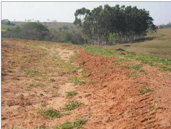
**Figura 37 - Terraceamento para detenção de enxurradas. Fonte: ANA (2014)**
