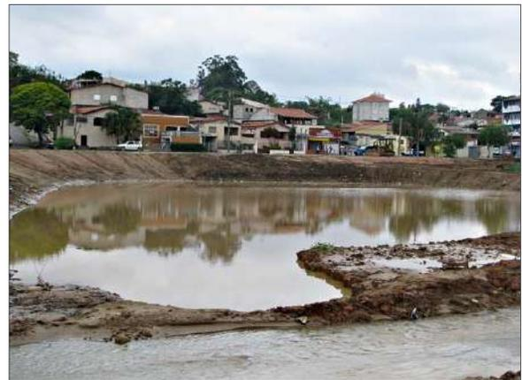
**Figura 38 - Modelo de bacia de detenção em Sorocaba-SP. Fonte: Saaesorocaba (2014).**
