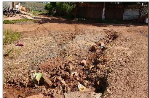
Figura 36 - Ausência de guias e sarjetas. Pavimentação danificada
